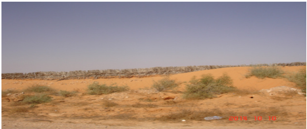
Photo 7. Protection avec des palmes de palmiers
