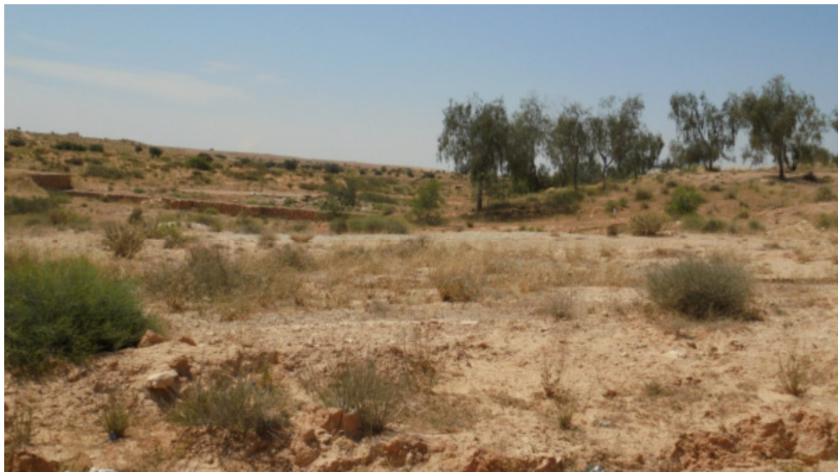
Photo 2bis. Ouvrage hydraulique au niveau de l'oued Ettaam
