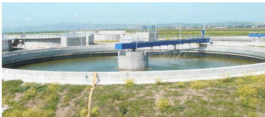
Station d'épuration El Attar
