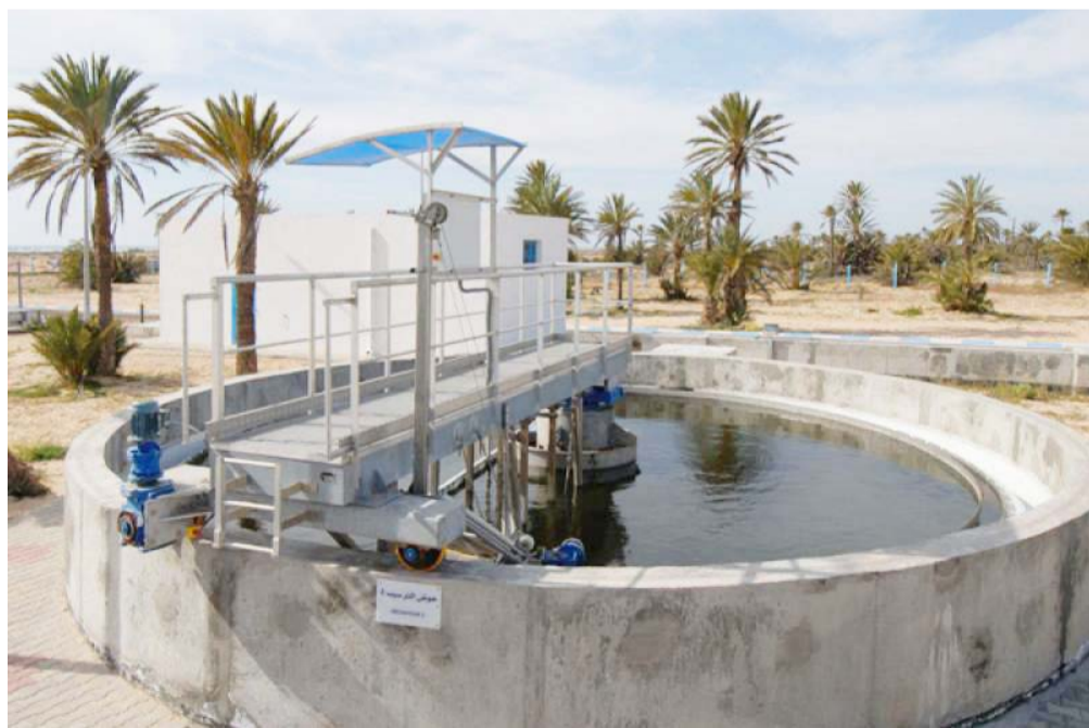
Station d'épuration Kerkennah
