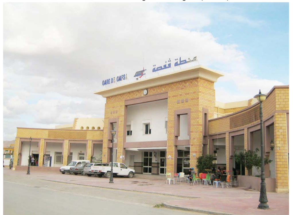
Gafsa : Le Sud - Ouest , un solde mégratoire négatif (- 3786)
